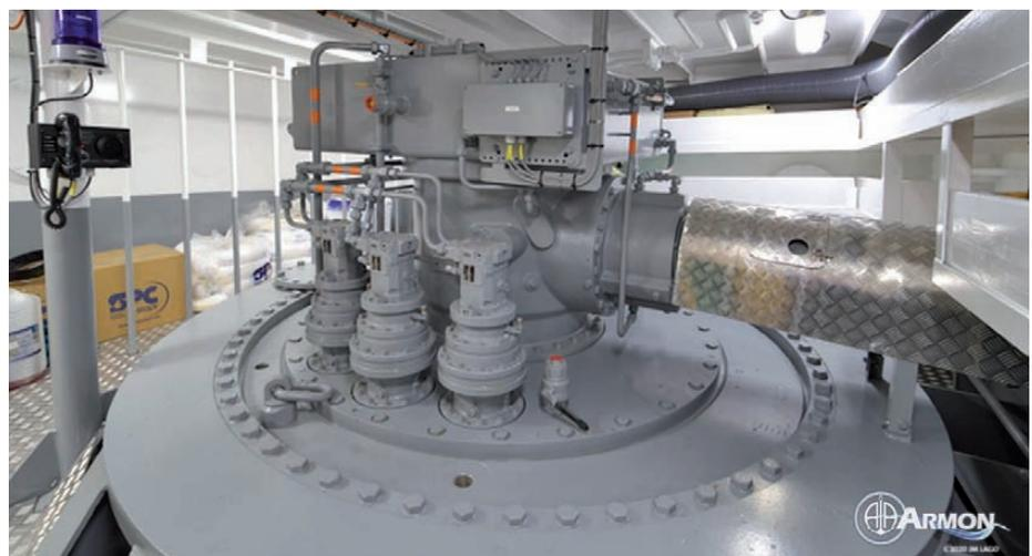
> Uno de los propulsores de Schottel que monta el remolcador.
