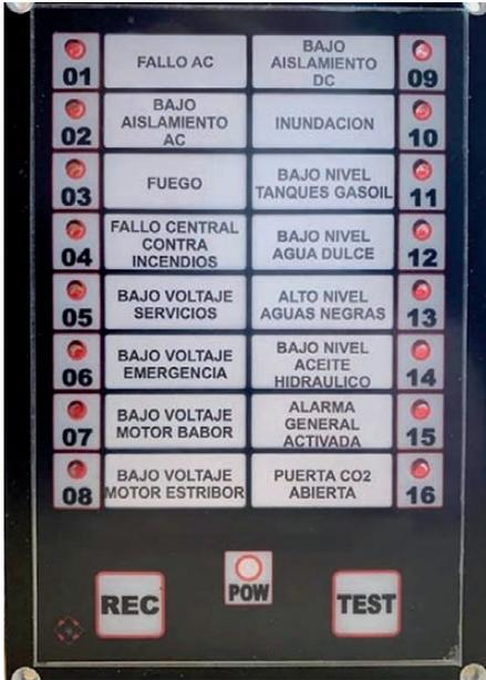
> Pantalla módulo de control y gestión de diferentes señales del sistema eléctrico.
