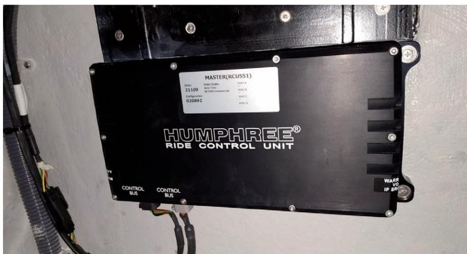
> Caja de controles del sistema de estabilización Humphree.
