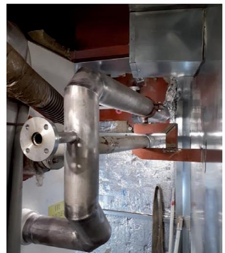
> Tuberías de MPM y Nippon Gases para la alimentación de los motores.
