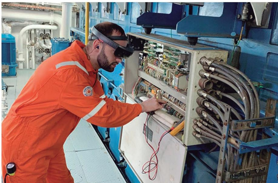
➤ Ensayo de inspección remota de equipos por parte del tripulante de un buque, siguiendo instrucciones en tiempo real remitida por técnicos de Bureau Veritas.
