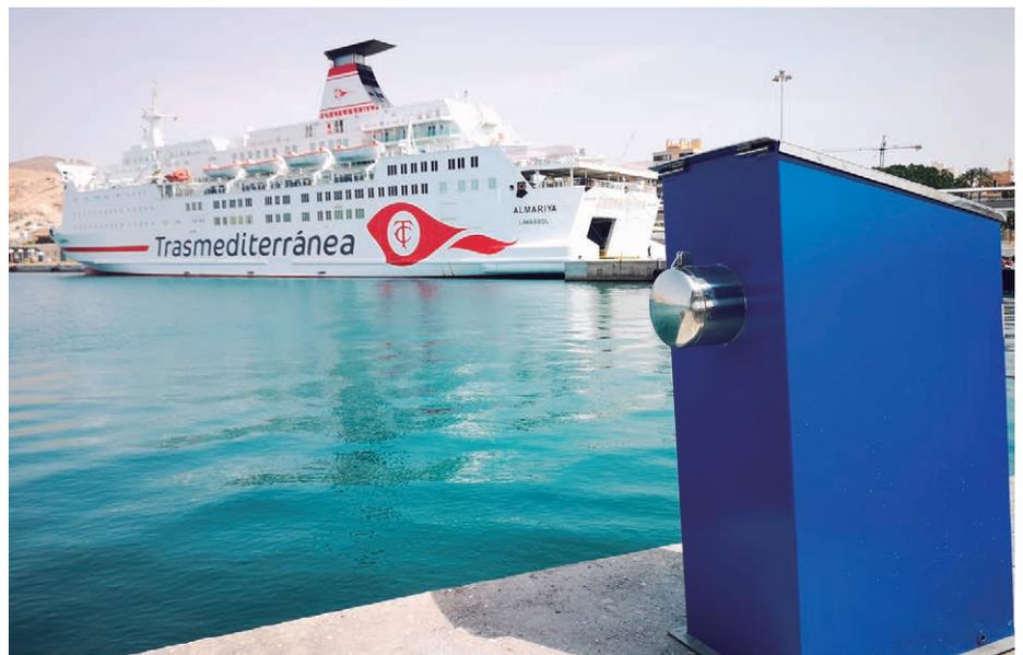
➤ Una de las hidrantes instaladas en los muelles del puerto de Almería, para acondicionar la seguridad del puerto en las operaciones de bunkering de GNL.
