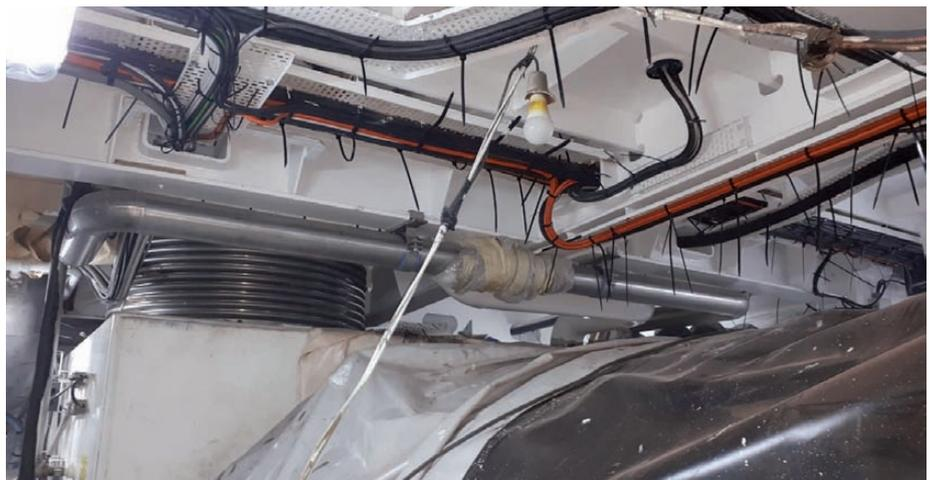
> Conducciones criogénicas de Nippon Gases GNL al tanque de almacenamiento.
