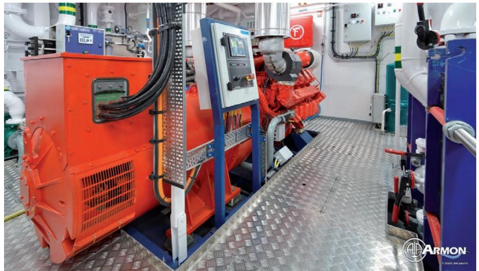
> Planta auxiliar, formada por motor Scania y alternador Lery Somer.
