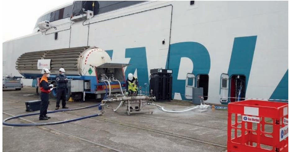
➤ Suministro de nitrógeno para la operación de secado, inertización y enfriamiento.
