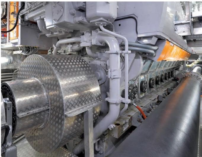
> Propulsión Dual Fuel de Wärtsilä, basado en cuatro motores de 16 cilindros en V.
