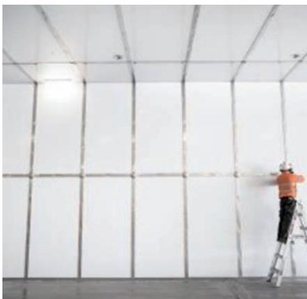
> Instalación de paneles aislantes en los espacios de carga rodada.
