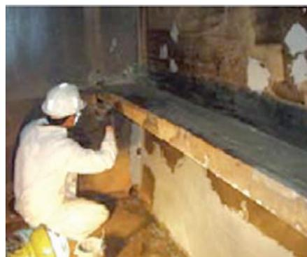
➤ Aplicación de Nova 5000 Barrier en el interior de un tanque de lastre.
