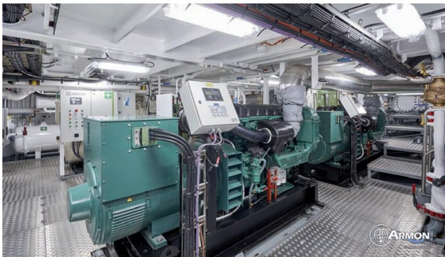
> Sala de máquinas del tangonero, con los dos generadores auxiliares eléctricos.
