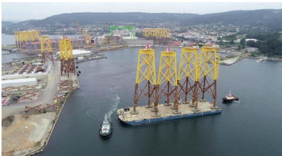
> Jackets completadas en la factoría de Navantia en Fene. La participación de Nervión Naval Offshore en la estructura se centra en la prefabricación de determinados componentes metálicos, como nudos y acero complementario, así como intervenir en el ensamblaje final de las jackets fabricadas por el consorcio Navantia-Windar.
