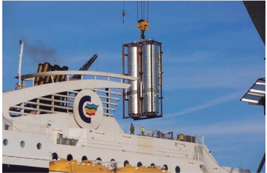
➤ Montaje del scrubber de un buque. La idea de Wärtsilä es aumentar las prestaciones del convencional lavado de gases de escape, diseñado para capturar el azufre, de forma que capture también el carbono.
