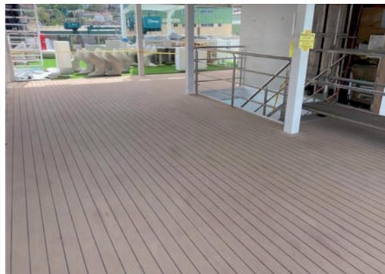
> Gracias a la técnica Purform utilizada en la instalación de la cubierta sintética en diversas zonas del ferry, se minimizan las emisiones de COV durante el proceso. El resultado obtenido en la aplicación de la gama Sika es de gran calidad y confort.
