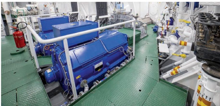
> Motores eléctricos del sistema de propulsión de Marelli Motori.
