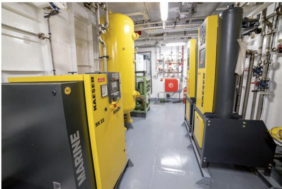
> Los compresores marinos y los secadores de adsorción KAESER instalados en la sala de máquinas, dotan al buque de una muy buena calidad de aire comprimido, con puntos de rocío de hasta  $-70^{\circ}\text{C}$  para complacer cualquier necesidad neumática a bordo.
