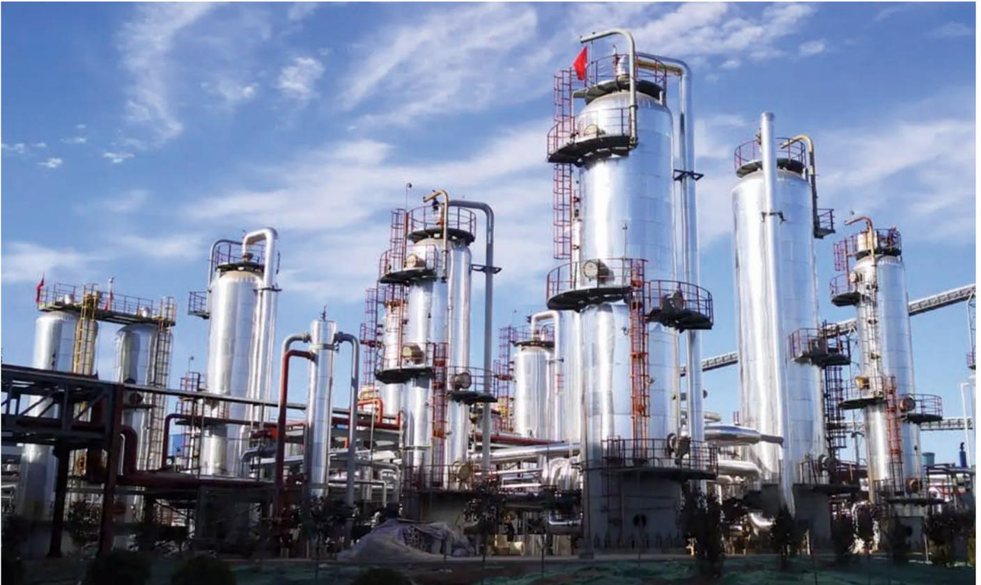
► La primera planta comercial para fabricar metanol a gran escala a partir de CO<sub>2</sub> e hidrógeno cumple ahora un año de funcionamiento, tras su puesta en marcha en noviembre de 2022 en Anyang (China). Tiene capacidad para producir hasta 110.000 toneladas de metanol al año.
